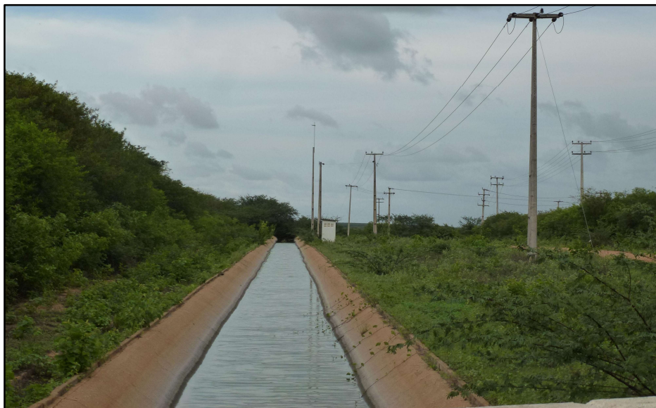
Canal Secundário do Projeto Irrigação Tabuleiros de Russas
