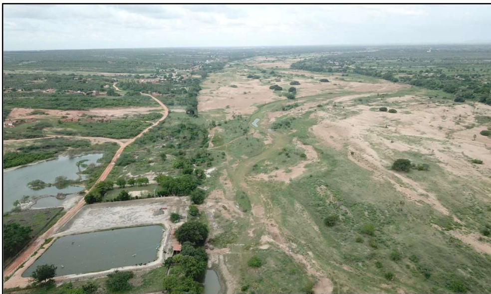
Tanques de Aquicultura e Leito Seco Rio Jaguaribe
