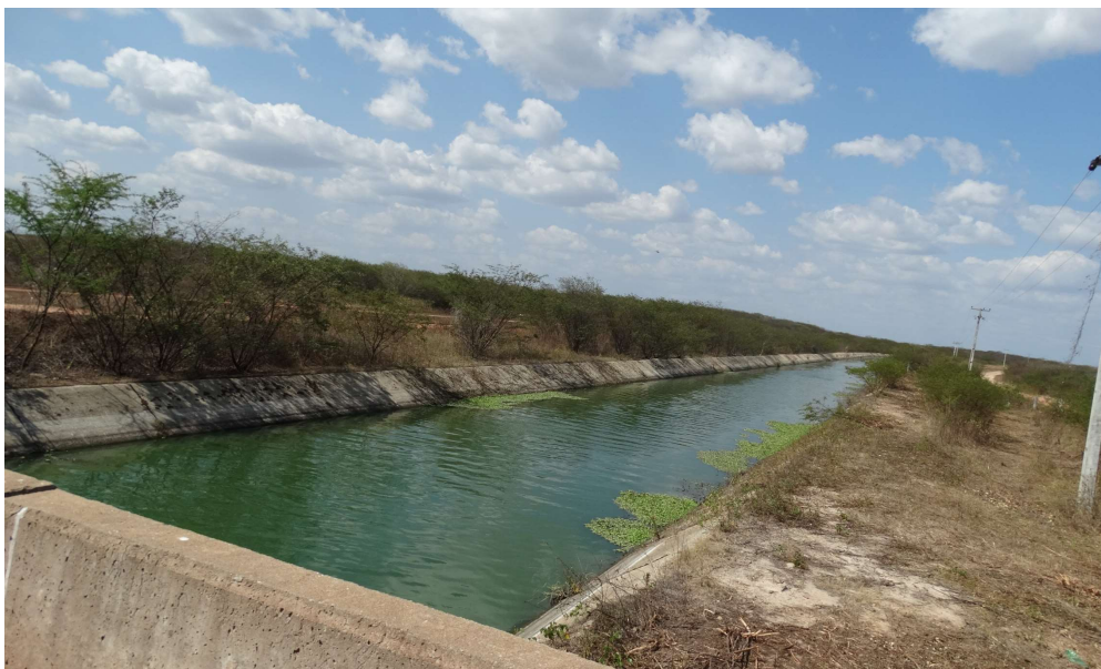
Canal Principal do Projeto de Irrigação Tabuleiros de Russas
