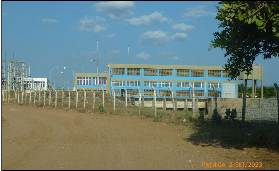
RH5 – Baixo Jaguaribe - Estação de Bombeamento do Perímetro Irrigado Jaguaribe-Apodi
