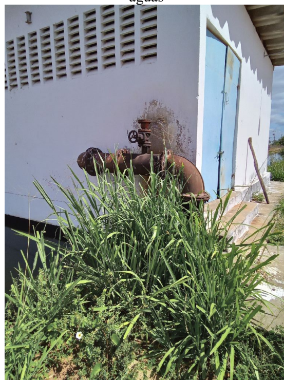
(h) captação de água em canal – eixão das águas
