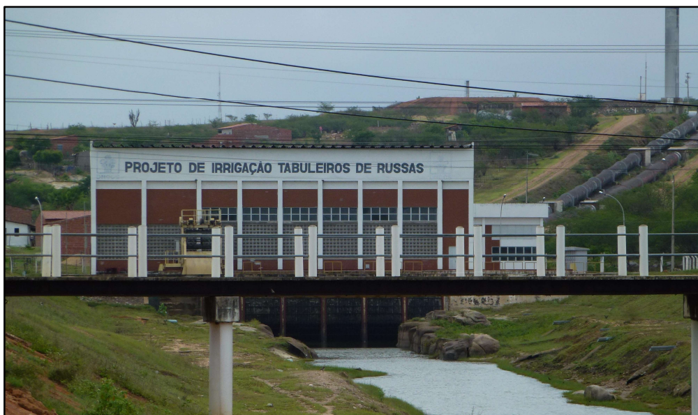
Casa de Bombas do Projeto Irrigação Tabuleiros de Russas
