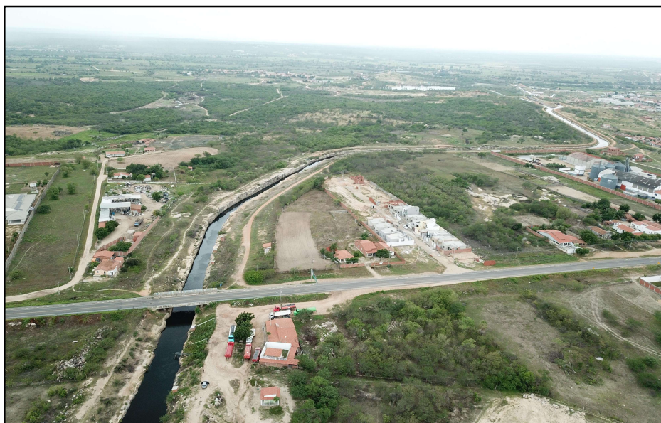
Canal do Projeto Irrigação Tabuleiros de Russas
